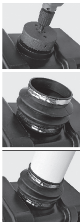
Рис. 9 Подсоединение вертикального подводящего трубопровода 110 мм (DN100)
