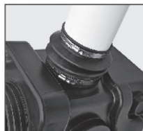
Рис. 10 Монтаж вентиляционного трубопровода
